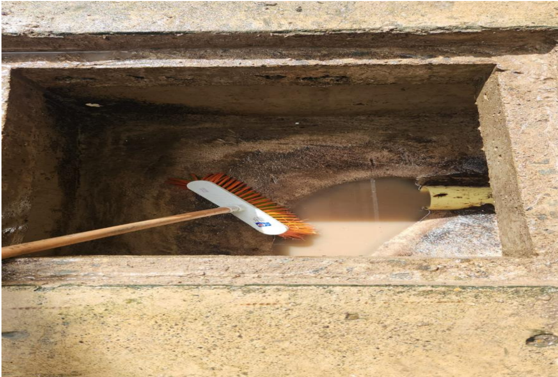
Fotografía 8. Mantenimiento de registros de aguas residuales.
