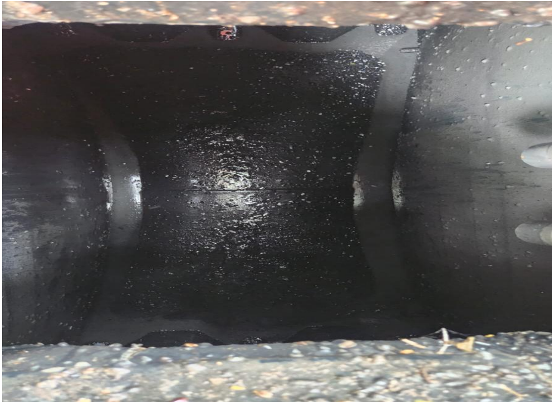
Fotografía 23. Limpieza y evacuación de aguas residuales de PTAR
