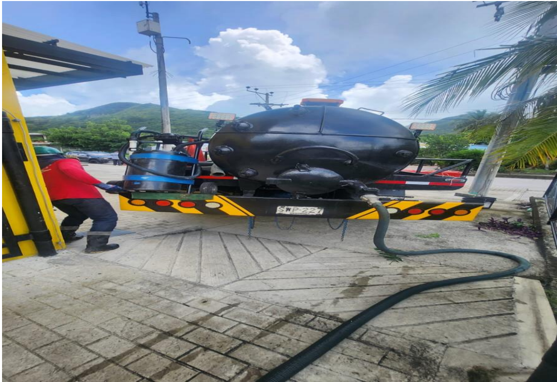
Fotografía 21. Limpieza y evacuación de aguas residuales de PTAR
