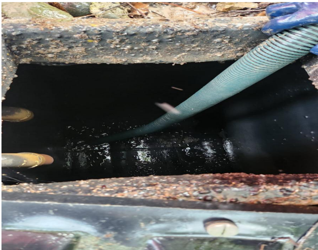
Fotografía 22. Limpieza y evacuación de aguas residuales de PTAR.
