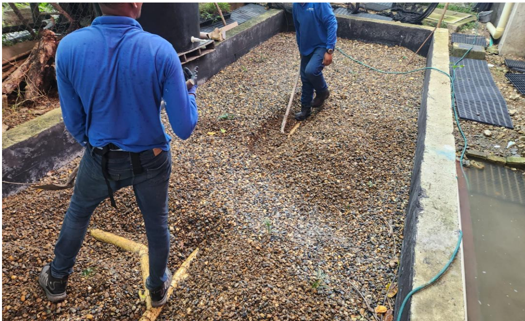
Fotografía 16. Mantenimiento de campo de infiltración
