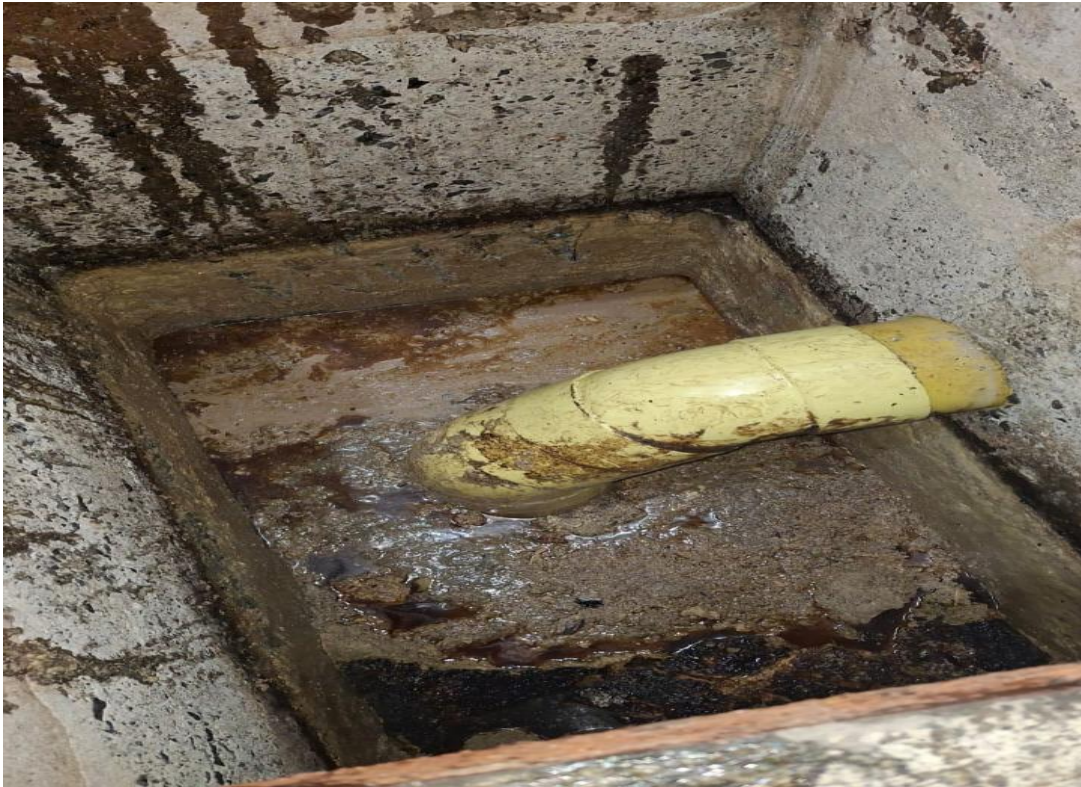
Fotografía 14. Mantenimiento de trampa de grasas Seccional Sena San Andrés Isla.
