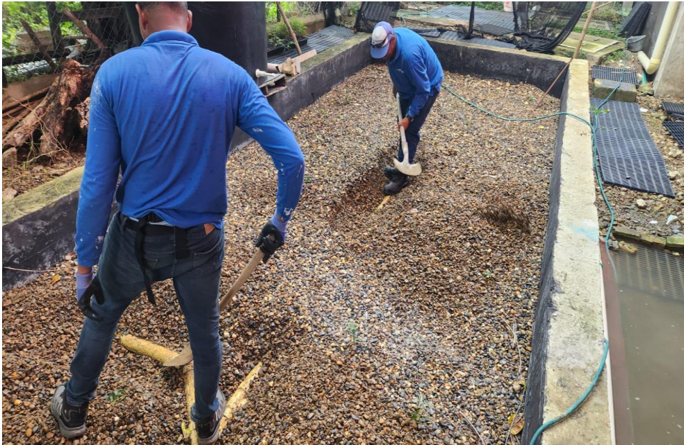
Fotografía 15. Mantenimiento de campo de infiltración
