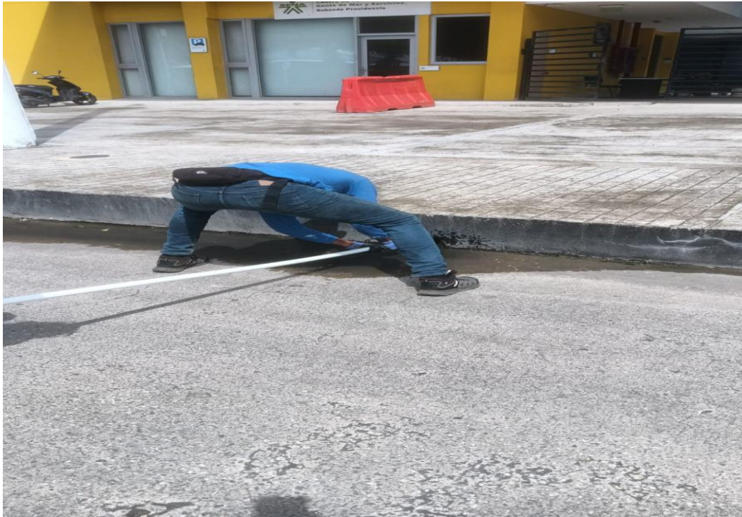
Fotografía 1. Limpieza de la Red de aguas residuales
