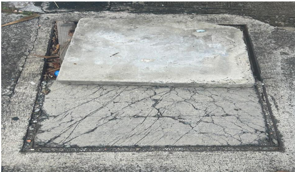
Fotografía 35. Tapas de registros anteriores deterioradas y en mal estado estructural
