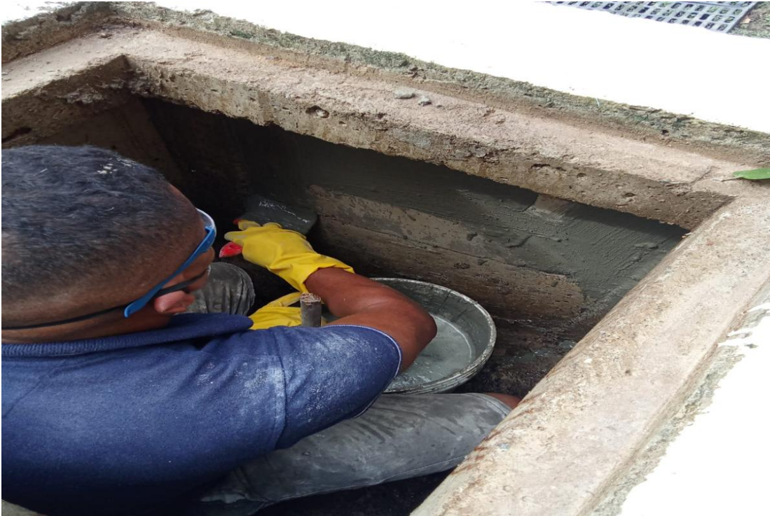
Fotografía 7. Mantenimiento de registros de aguas residuales, impermeabilización
